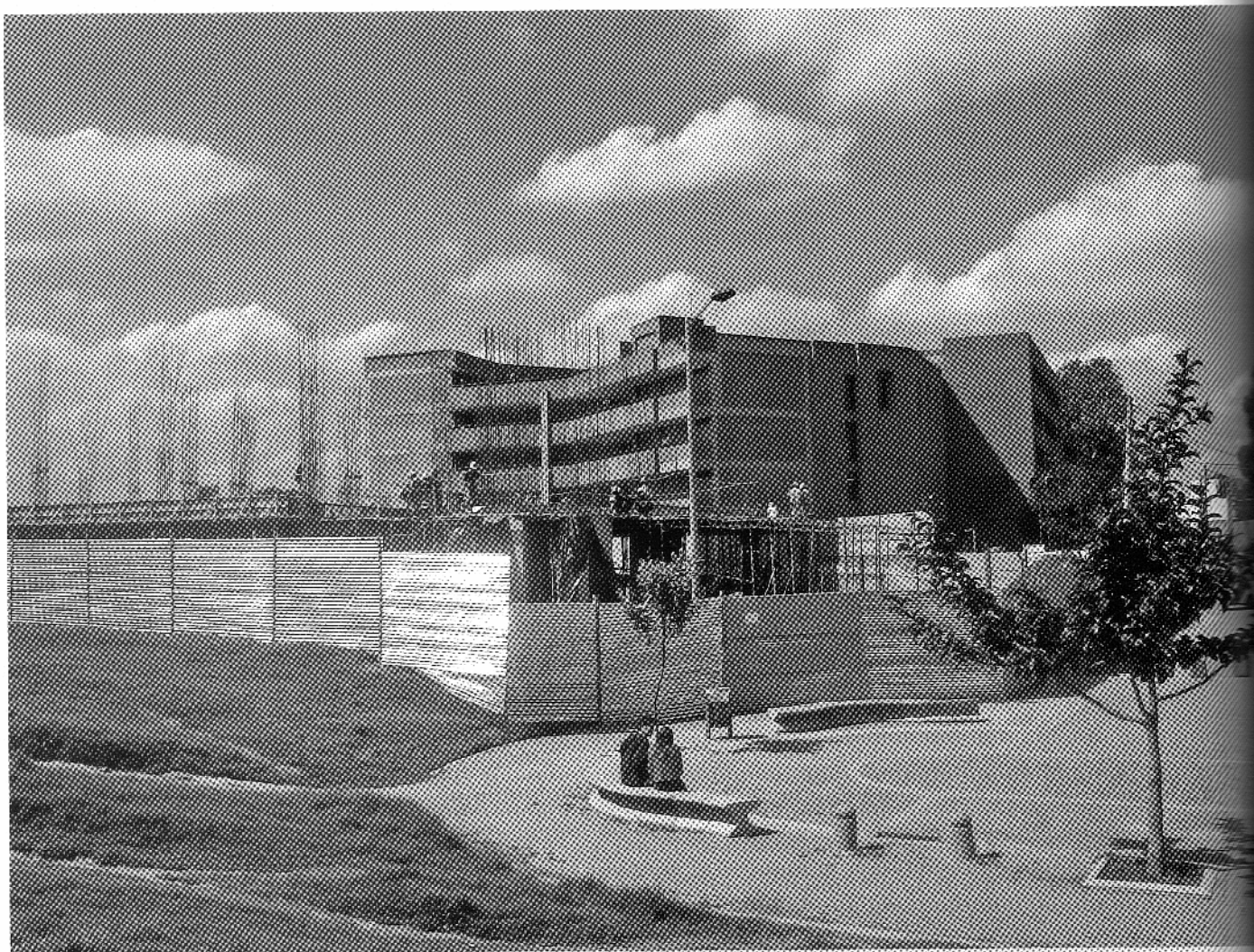
Fachada posterior del edificio central de la Corporación Universitaria Minuto de Dios.
