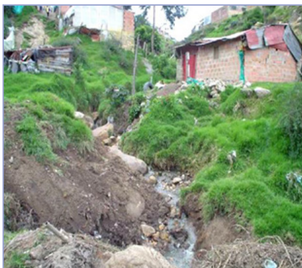
Fotografía No. 1. Viviendas en Zonas de Riesgo Quebrada Limas. Fuente: DPAAE.
